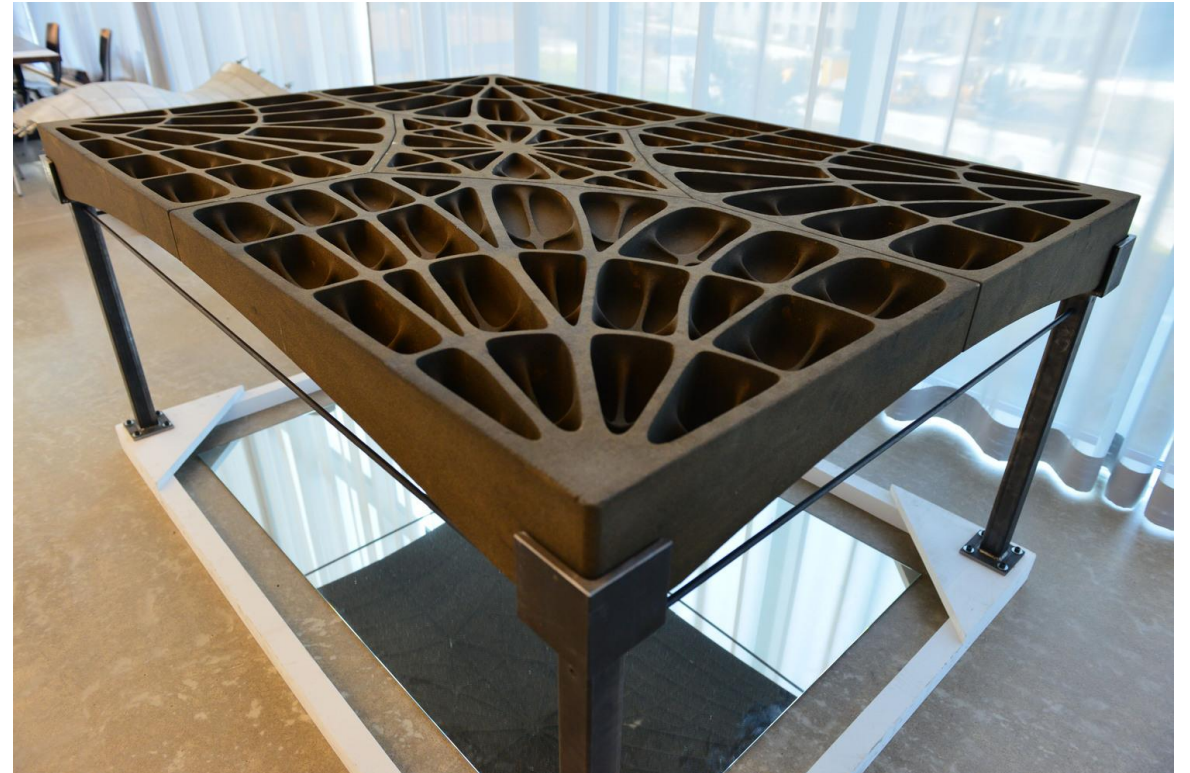
Samonosná nevyztužená konstrukce stropnice ( eth.com )
