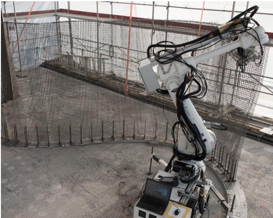
Robotická fabrikace ocelové armatury ( 3dprintingindustry.com [online])
